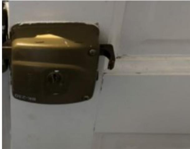
*Imagen 1. “Cerradura de puerta de cocina “defectuosa””; reportado por propietario de la vivienda AE Lt15.*
